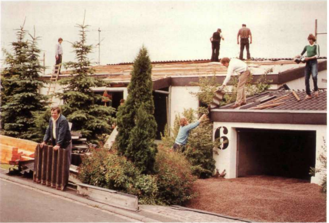
La cubierta permeable de chapas onduladas de fibrocemento..
