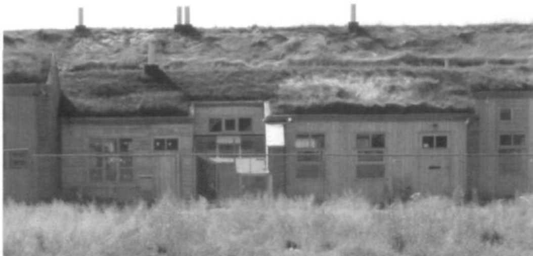
4.7 Urbanización de techos de césped Laher Wiesen, Hannover (Alemania)
