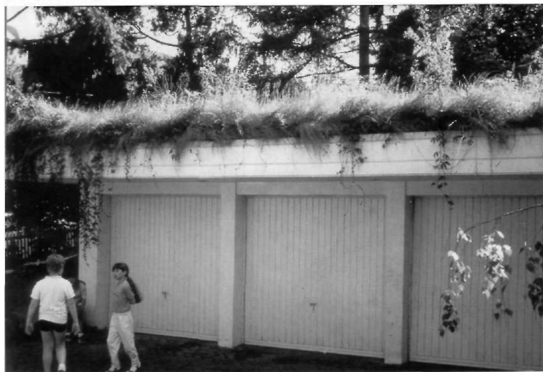
5.14 Garaje con techo de césped
