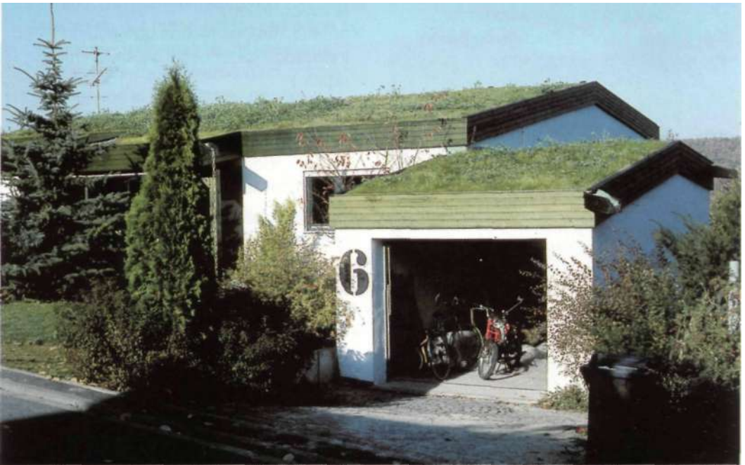
. fue sustituida por un techo verde en Kaufungen (Alemania)
