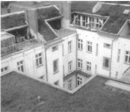
2.5 Ampliación sobre azotea con enjardinado de techo, Berlín-Kreuzberg (Alemania)
