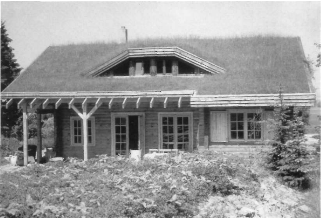
12.1 Techo de césped con lucarna integrada
