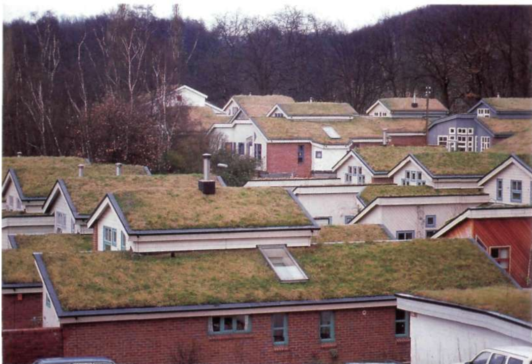
Urbanización de techo verde en Düsseldorf-Unterbach (Alemania)
