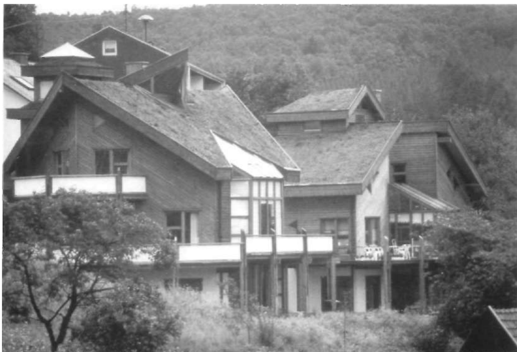
5.12 Techo de césped con 45° de inclinación, Siegen-Oberscheiden (Alemania)
