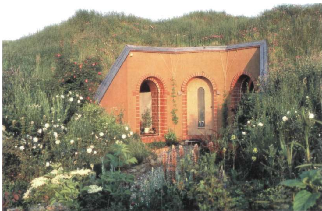
2.8 Techo de césped sobre una cúpula de tierra, Urbanización ecológica en Kassel (Alemania)
