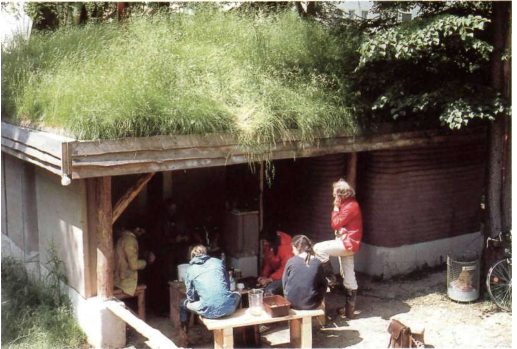
Edificio experimental con muros de tierra y techo enjardinado, Universidad de Kassel (Alemania)
