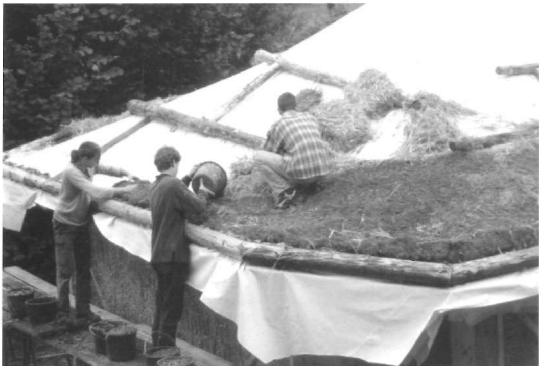
10.6 Montaje de sustrato
