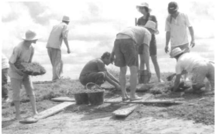
5.17 a 5.19 Realización de un techo verde de bajo costo, Viamáo (Brasil)
