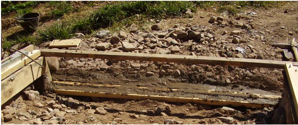
Soporte central del colector
