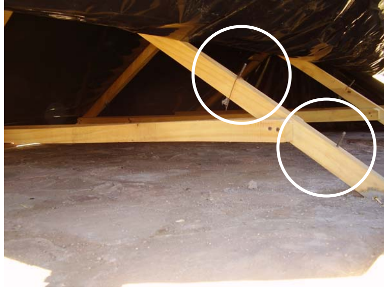
Detalle de ubicación de los tornillos
