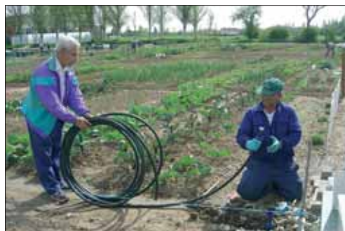
14.2: instalación de la tubería general de polietileno de una pulgada (25,4 mm) que va conectada a la toma de agua
