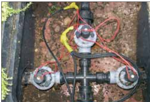
3.11: electroválvulas. Nos permiten regar y/o fertilizar los sectores del huerto que deseemos
