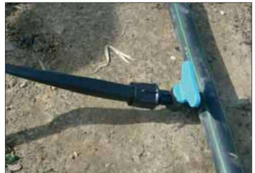
14.6: inserción de la cinta de riego por goteo
